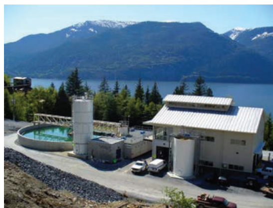
NOWOCZESNA INSTALACJA OCZYSZCZANIA WODY
